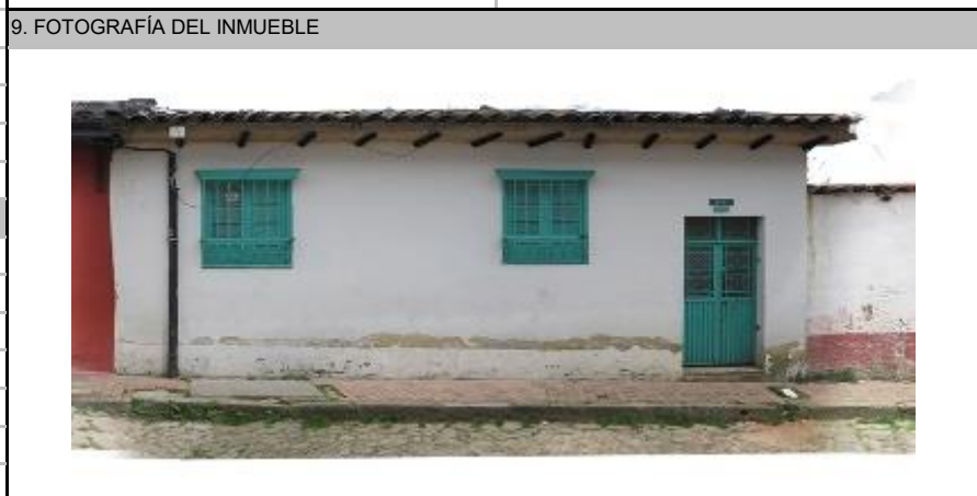
Fuente: Equipo Fotografía PEMP Patrimonio Inmueble
